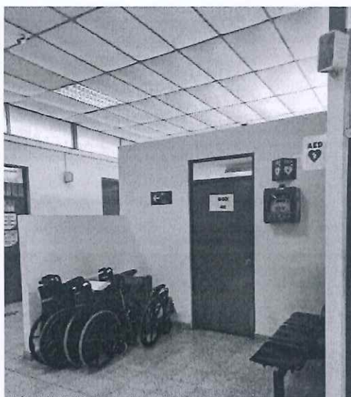
Demolición tabique a media altura
