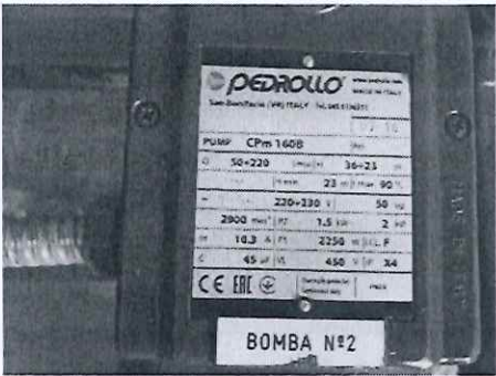
2. Equipos Agua Potable (PEDROLLO-CPm 160B)
